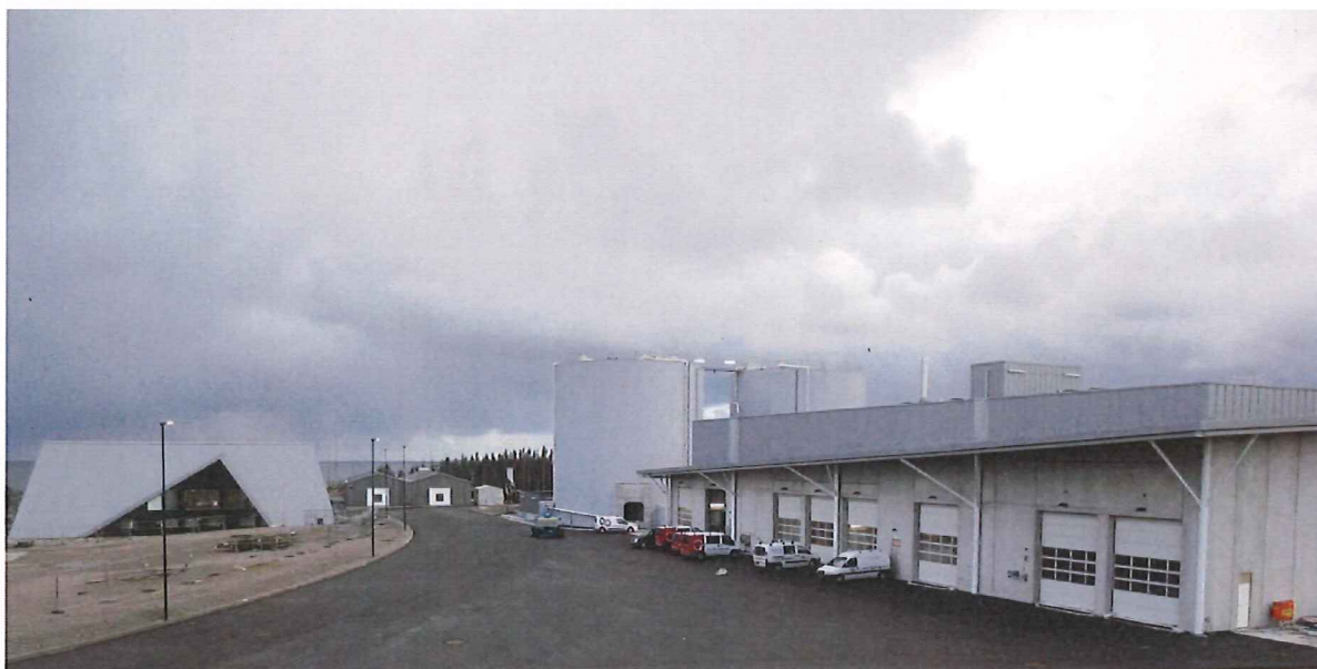
Slammottak og råtnetanker.
