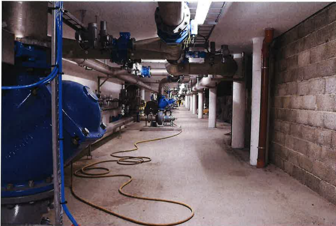
Pumpekjeller for retur- og overskudd slam
