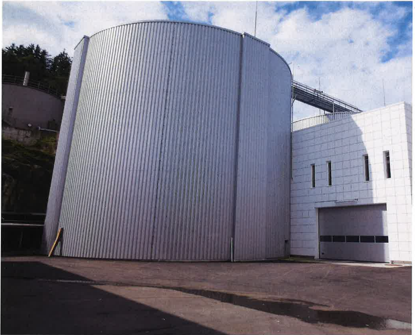
Bilde viser fra venstre ny råtnetank) m/ nytt mellombygg og eksist. buffertank
